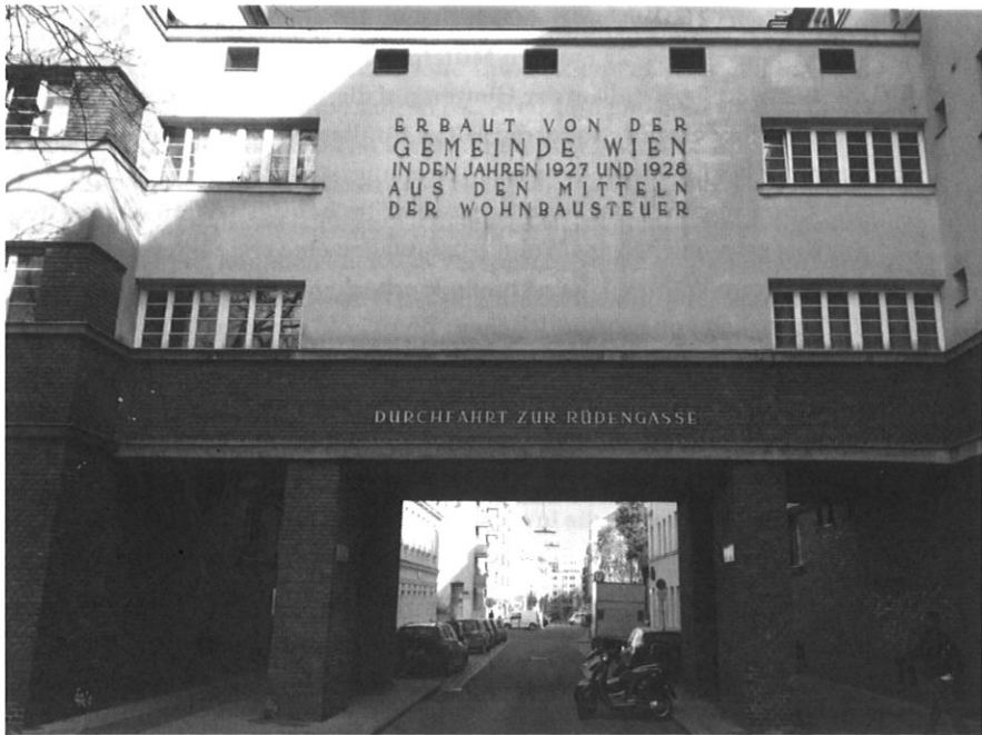
2 Wohnbausteuer-Inschrift auf Rabenhof, Gemeindebau im 3. Bezirk.
